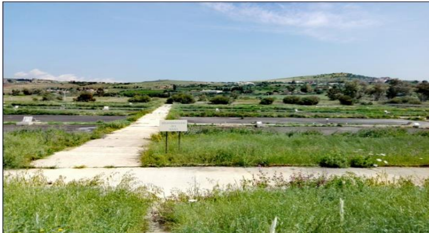
Figure 15 : Séchage des boues activées à l'air libre.
