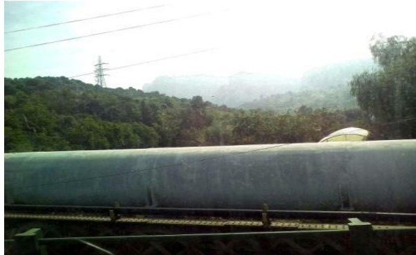
Figure 5 : Canal principale des eaux usées qui alimente la STEP Ibn Ziad.
