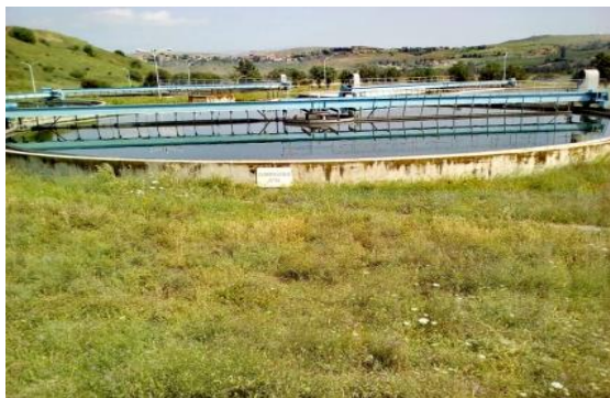
Figure 12 : Clarificateurs circulaires.
